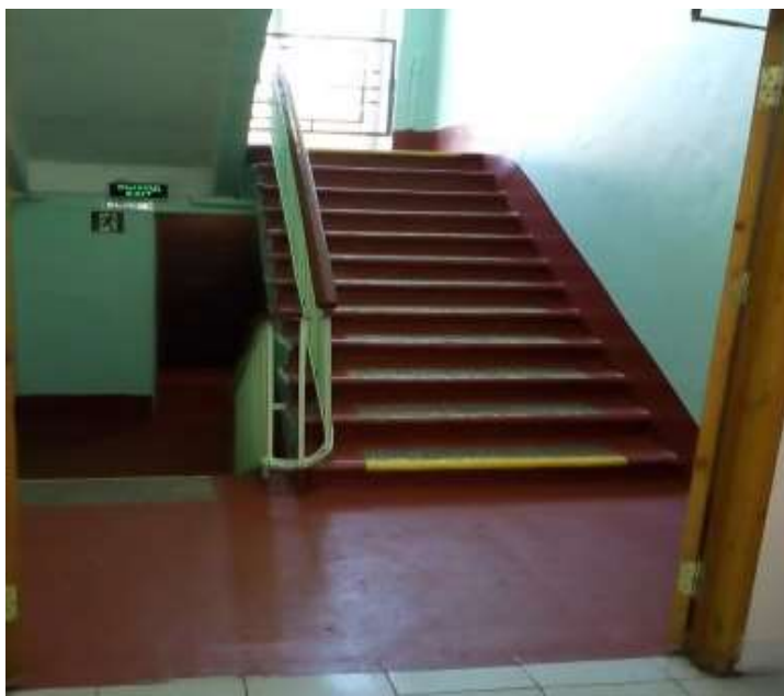
Лестница и запасный выход
